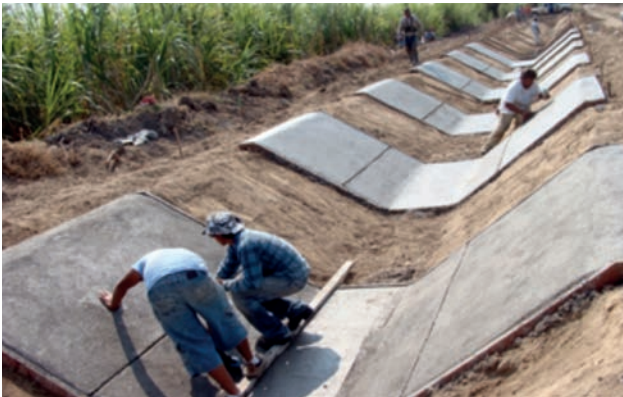
FIGURA 5.2.10. Trabajo de revestimiento de canales
