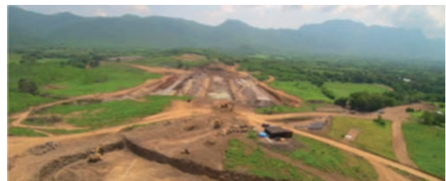
FIGURA 5.2.15. Panorámica del desarrollo de los trabajos en la presa El Chihuero
